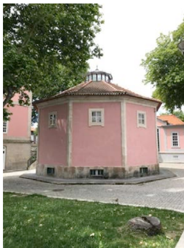
Figura 5: Imagem atual do pavilhão para doentes furiosos do HCF (fotografia do autor)
